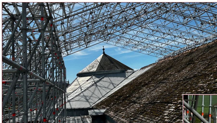
Le dôme qui coiffe le portail principal du Grand Cloître sous les tubulures de sa dentelle de fer.
