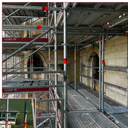
Les pierres dorées de la façade du Grand Cloître prisonnières d'un carcan d'acier le temps du chantier.
