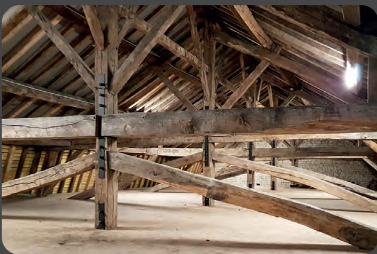
Cette année, la charpente a été entièrement reprise, et, si une grande partie des "fermes" sont d'origine, la totalité des liteaux, lattages et voligeages, permettant la fixation de la couverture, ont été remplacés.
